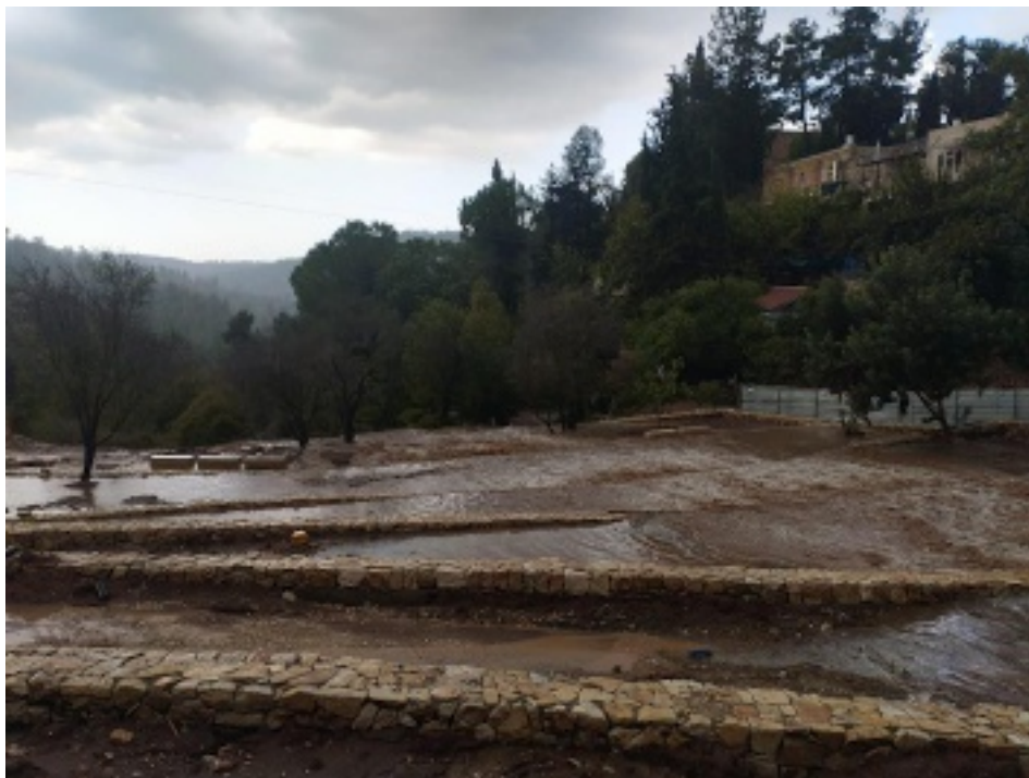
איור 8- הצפות בטרסות לכיוון הבוסתן- מעיד על מערכת בסיפיקה עודפת כבר כיום
